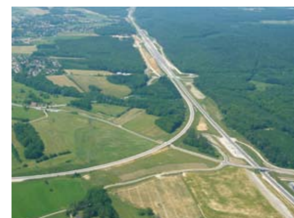
Raccordement de la LGV à la gare de Besançon-Viotte - Auxon-Dessus (25).
