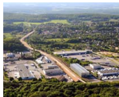
Vue aérienne de la liaison entre les deux gares.
