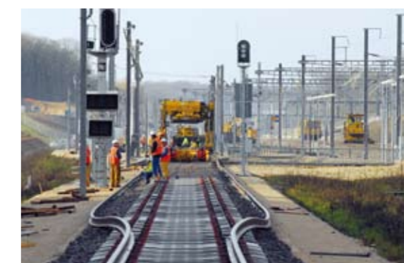
Pose de voie sur la LGV Rhin-Rhône.
