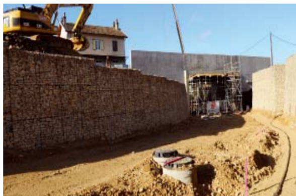
Terrassement de la nouvelle RD 5 - mur en gabions à proximité du pont-rail - Miserey-Salines
