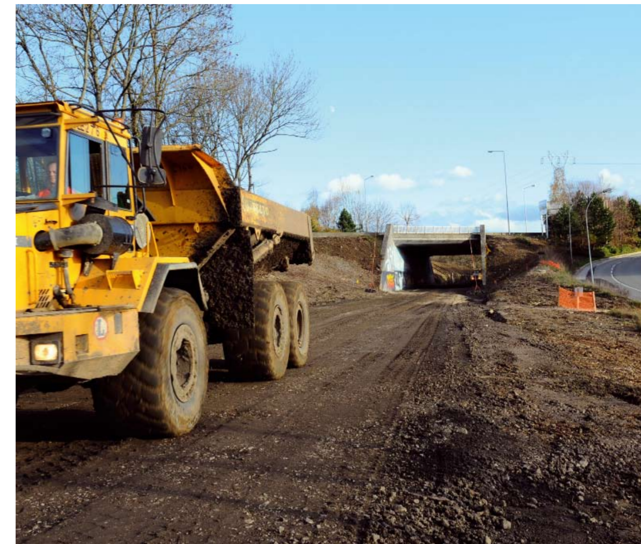
Travaux à proximité de la rue du Vallon - Ecole-Valentin
