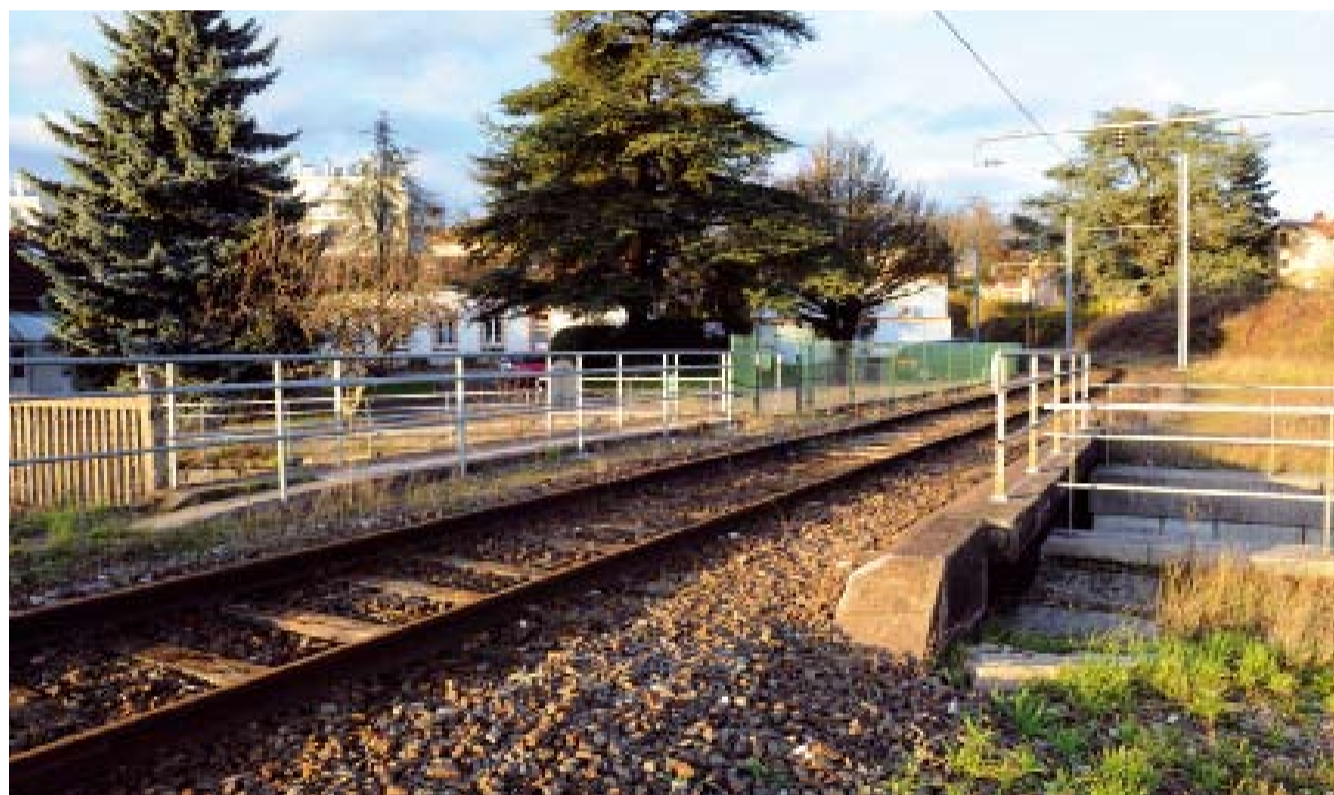
► Pont-rail Nicolas Bruand vu de la rue du Chasnot - Besançon
