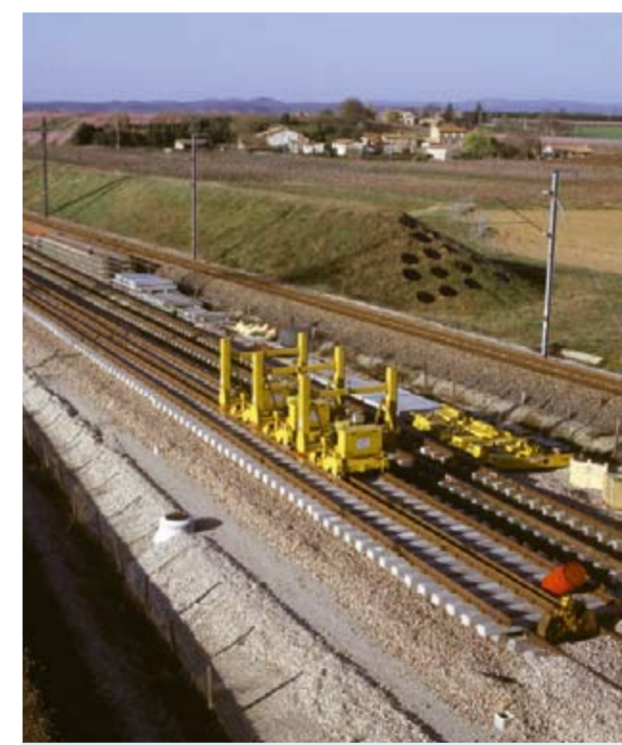
Exemple de merlon acoustique
