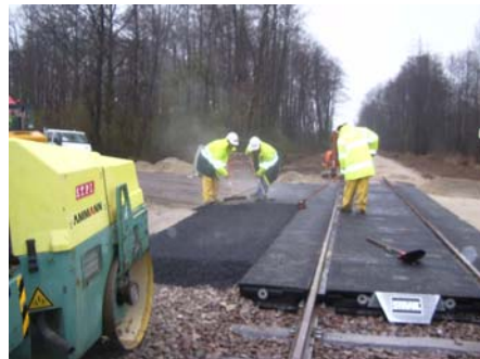
Passage à niveau
