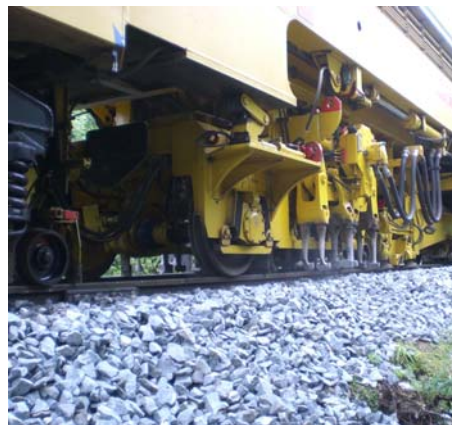
Bourrage de la voie
