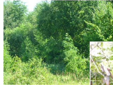
Déboisement de la plateforme
